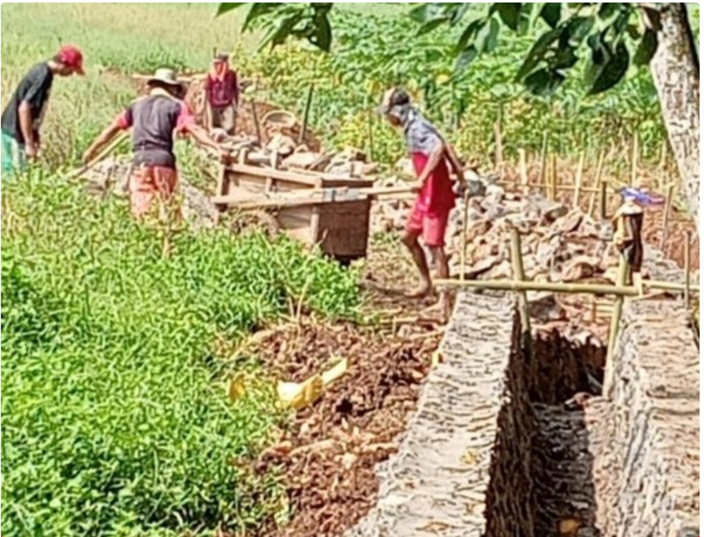
Warga Desa Banyubiru Kecamatan Labuan Bangun Drainase
