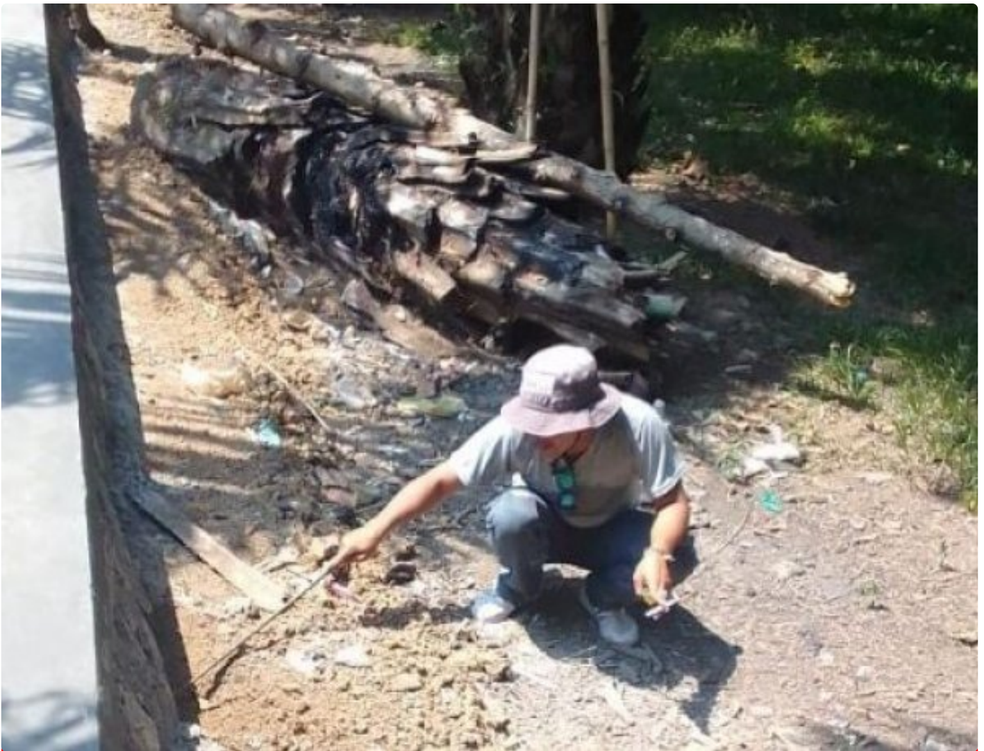
Proyek TPT Desa Perdana Diduga Sarat Penyimpangan dan KKN
